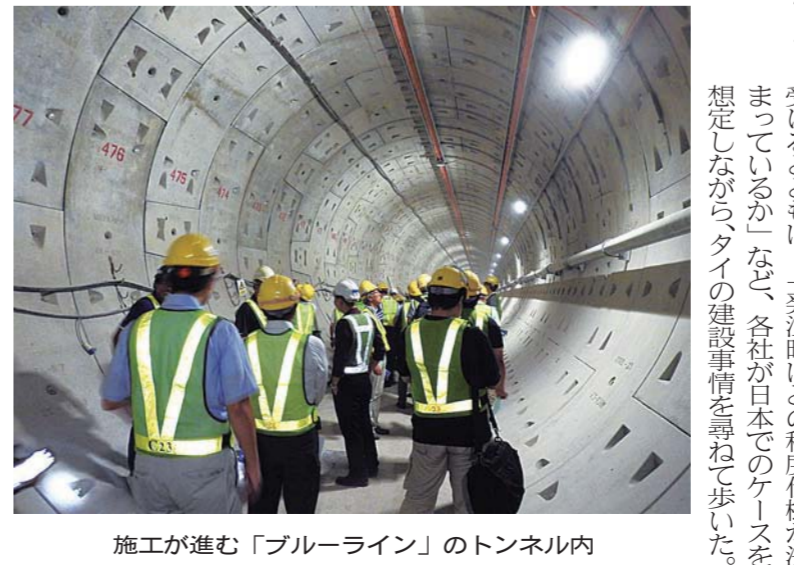
施工が進む「ブルーライン」のトンネル内
